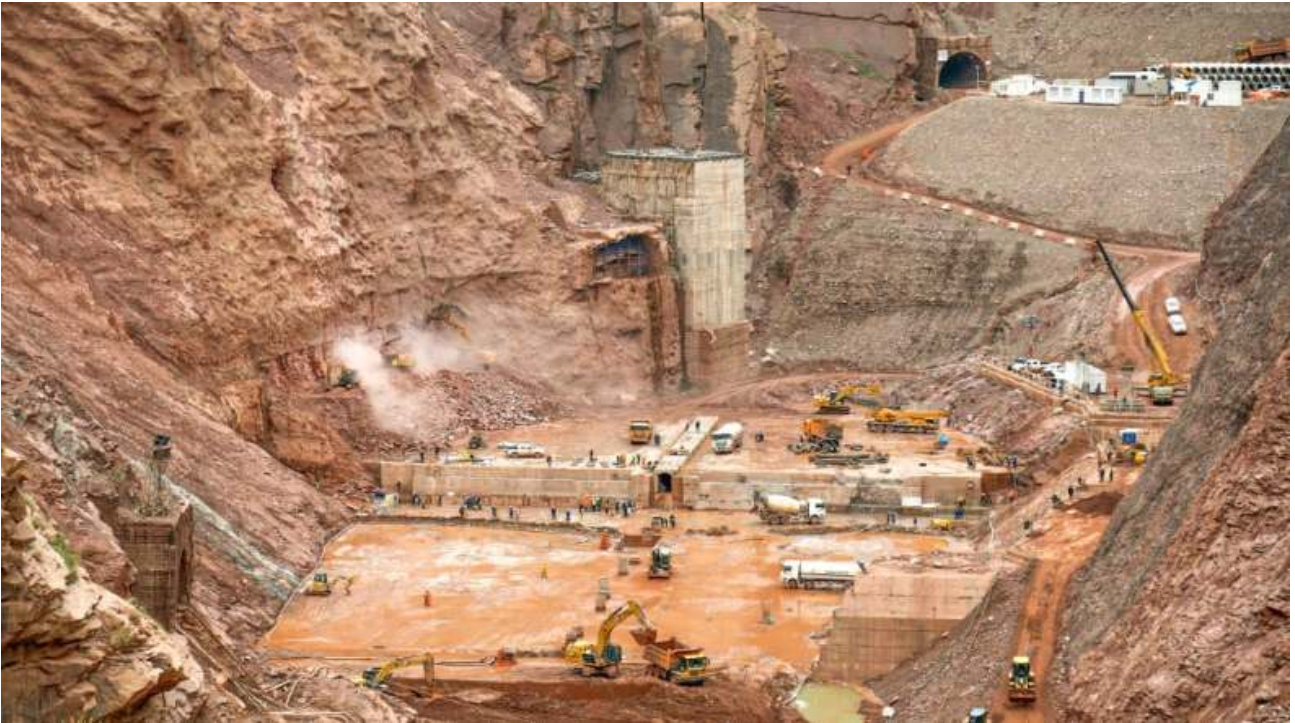
[그림 01: ROGUN 수력발전소 건설 현장]
