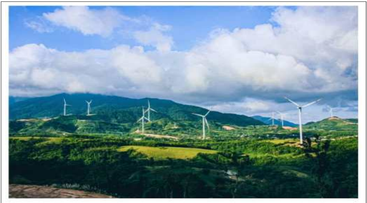
베트남 중부 Quang Tri성에 위치한 Gelex Quang Tri 1, 2, 3 풍력 발전소. 사진 출처: Gelex
